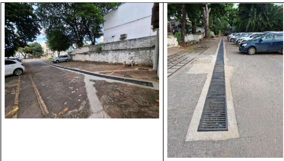
Figura 46: Ampliação e execução de novas grelhas de captação de água pluvial - Bloco L - Área 4
