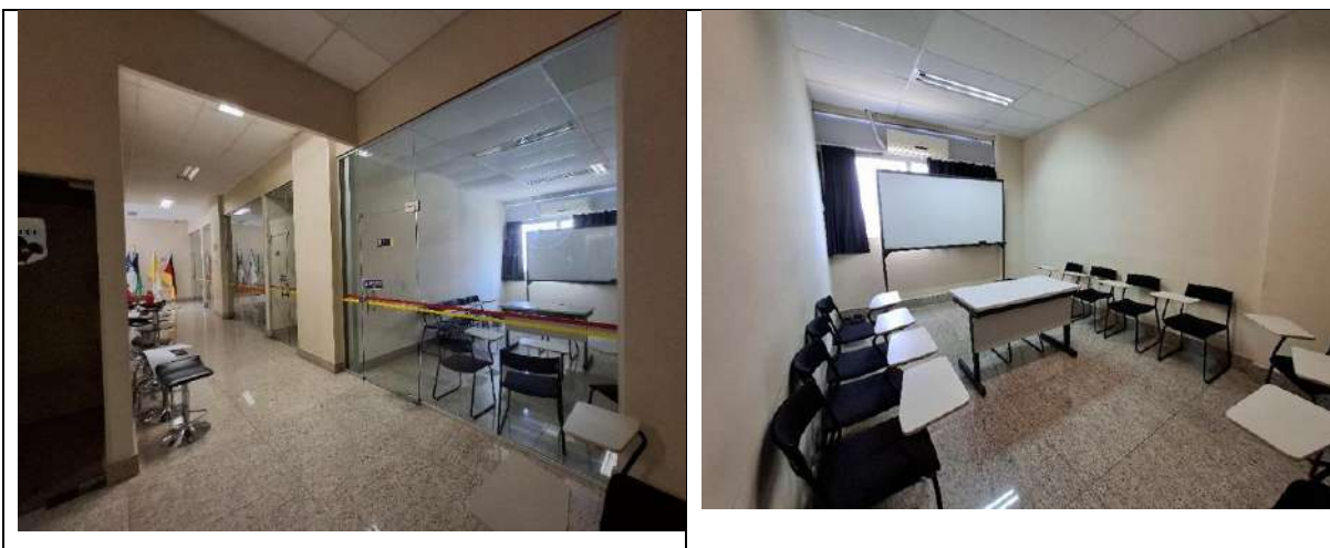
Figura 11: Adequação de mais 03 salas de aula para a PUC Idiomas
