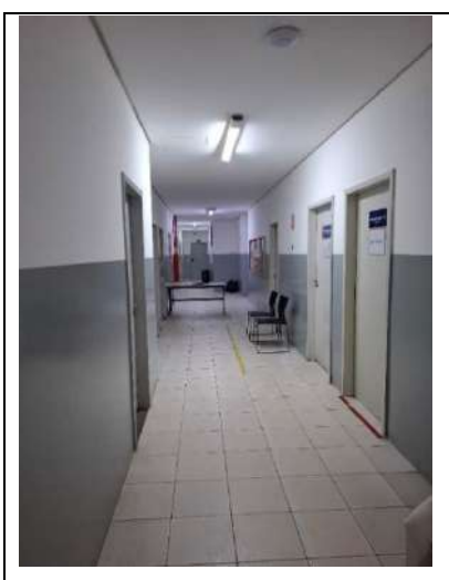
Figura 61: reparos no espaço acadêmico da PUC Goiás na Santa Casa e manutenção geral
