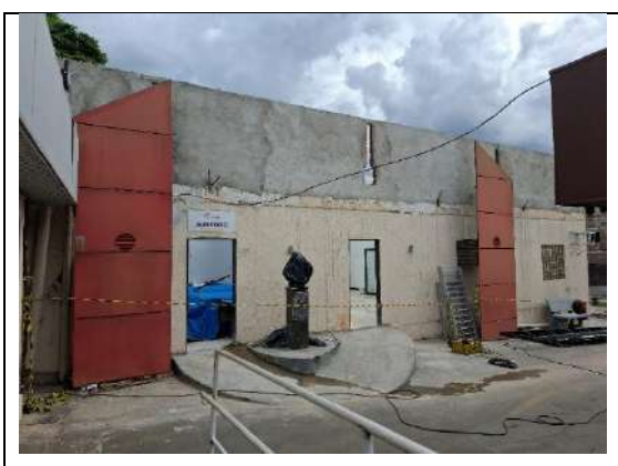
Figura 62: Adequação de estrutura de cobertura
