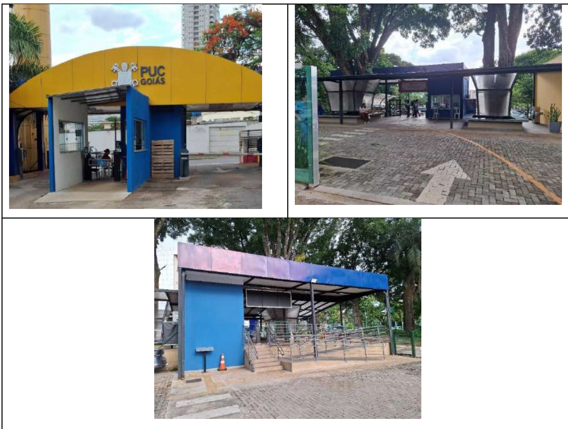
Figura 41: controle de acesso - Área 4 - construção de guarita de acesso; implantação de anel de segurança
