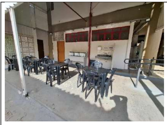
Figura 45: Adequações das antigas salas do mestrado e da secretaria do Bloco L em duas salas acessíveis - Bloco L e do espaço de alimentação
