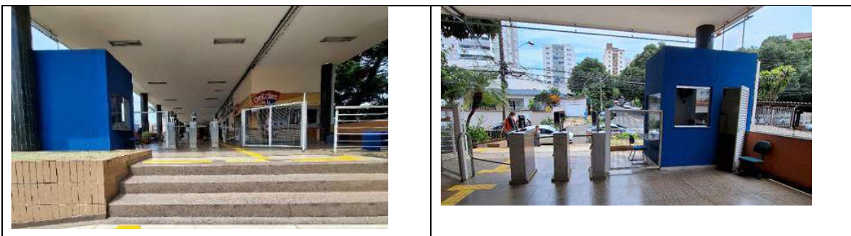
Figura 47: Controle de acesso - Área 5
