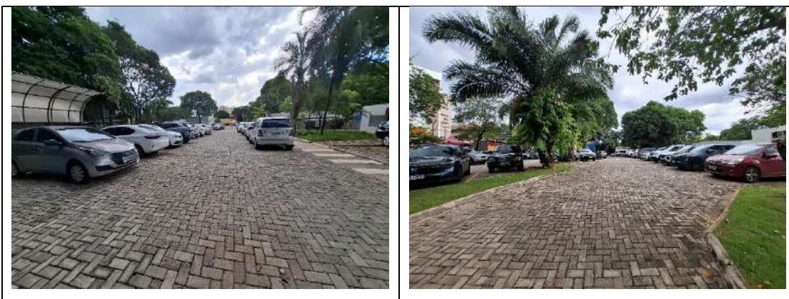
Figura 42: Pavimentação dos estacionamentos da Área 4 - antigo Bloco G
