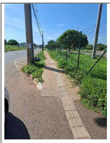
Figura 49: Execução da Calçada Acessível Campus II
