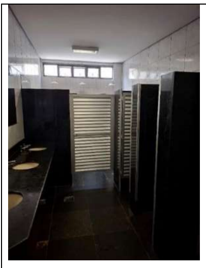
Figura 43: Adequação do vestiário - Bloco C (instalação de chuveiros)
