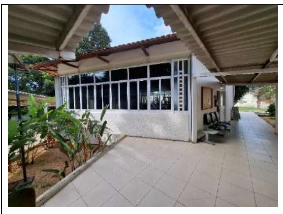
Figura 53: Campus 3 - Pintura do Bloco B e Mecatrônica (Pintura C-3)
