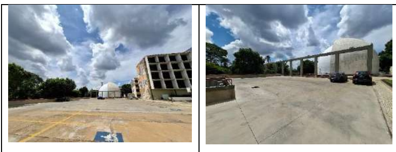
Figura 35: Reparo no Piso do Estacionamento da Área 2 (em frente ao DCE)
