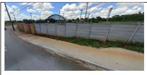
Figura 48: Complementação do Muro do Campus 2 – Avenida Engler
